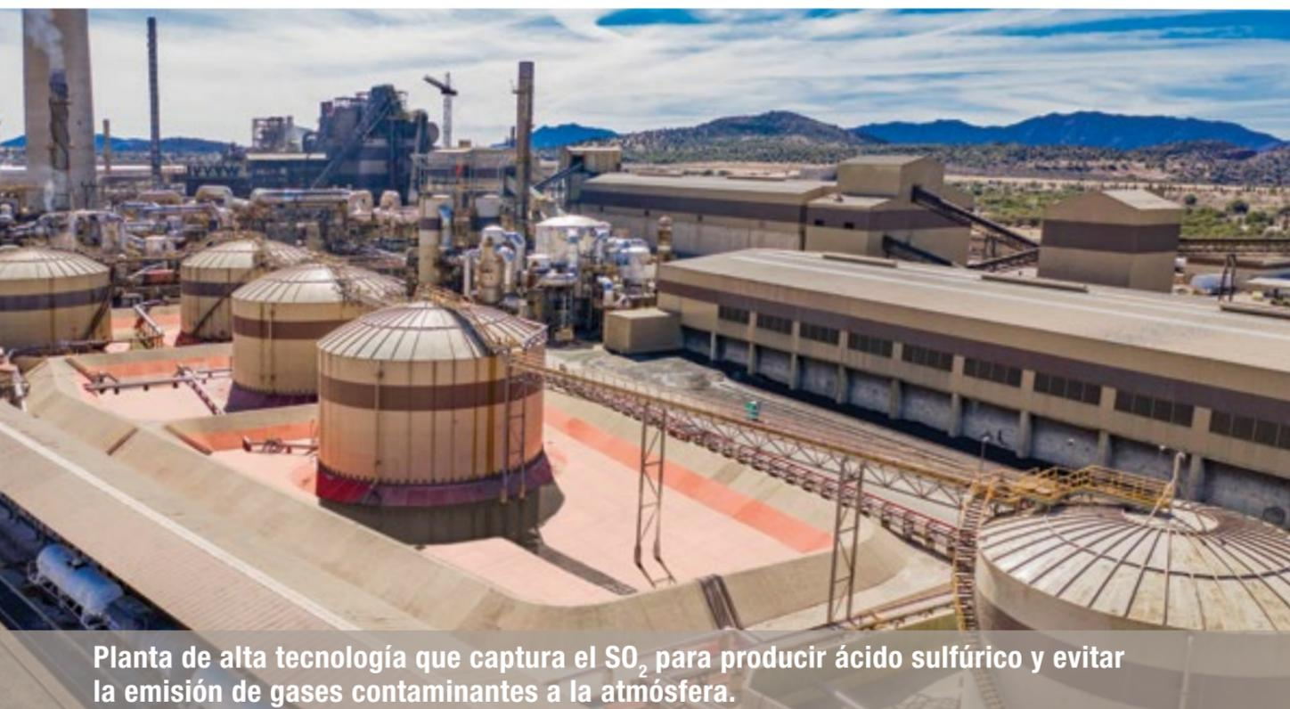
Planta de alta tecnología que captura el  $\text{SO}_2$  para producir ácido sulfúrico y evitar la emisión de gases contaminantes a la atmósfera.
