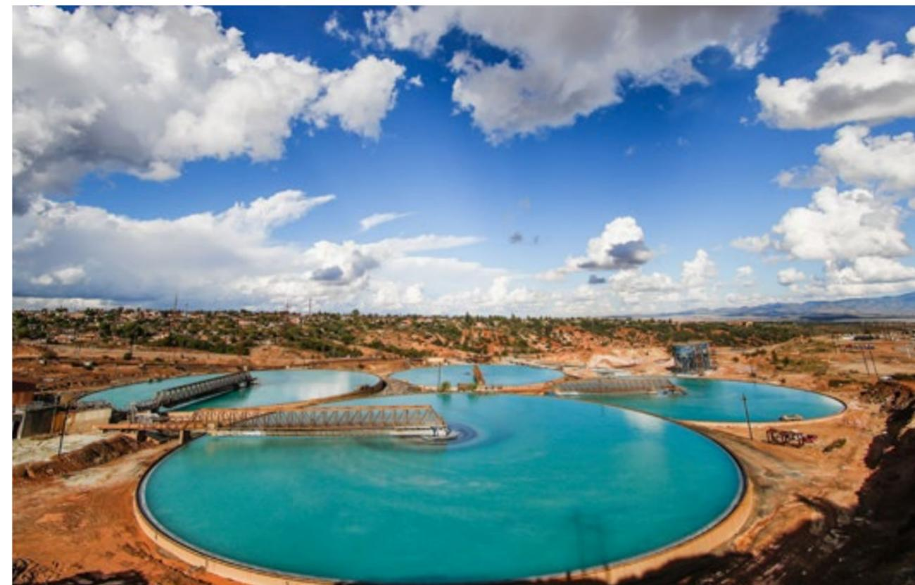
En los tanques espesadores de jales recuperamos 85% del agua del proceso minero.
