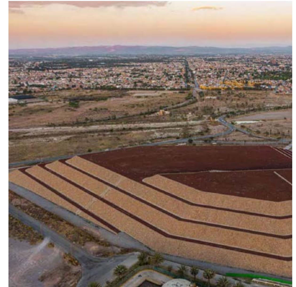
Estructuras de depósitos para remediación de suelos, San Luis Potosí, México
