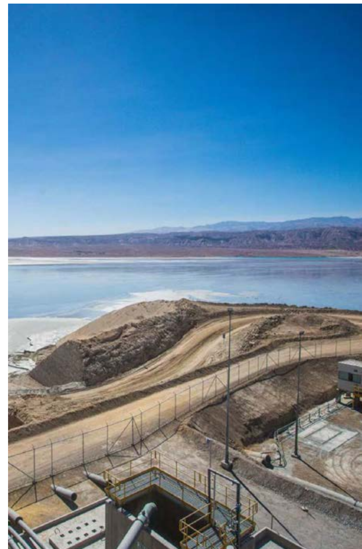
Depósito de residuos en Quebrada Honda, Toquepala, Perú
