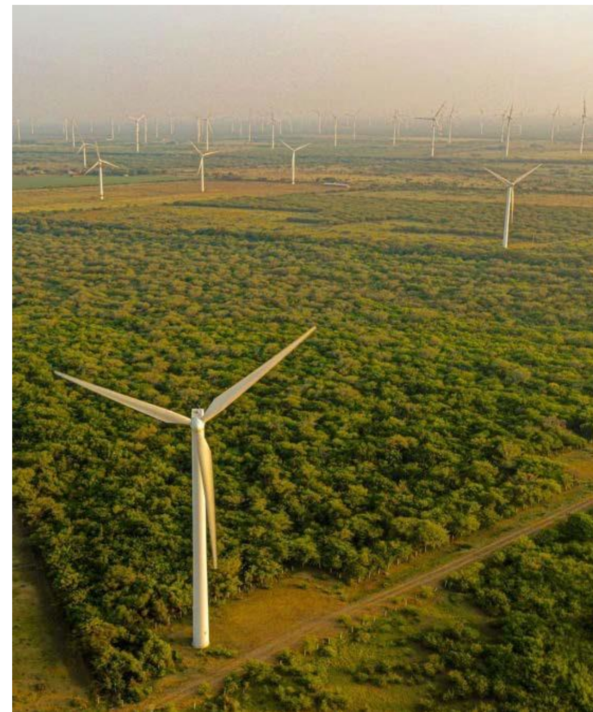
Parque Eólico El Retiro, Juchitán, Oaxaca, México
