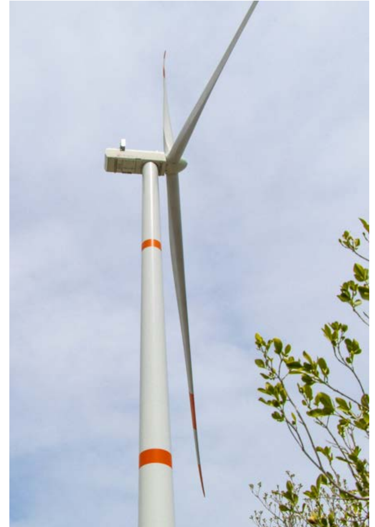
Parque Eólico Fenicias, Nuevo León, México; que abastecerá de energía renovable a las unidades mineras
