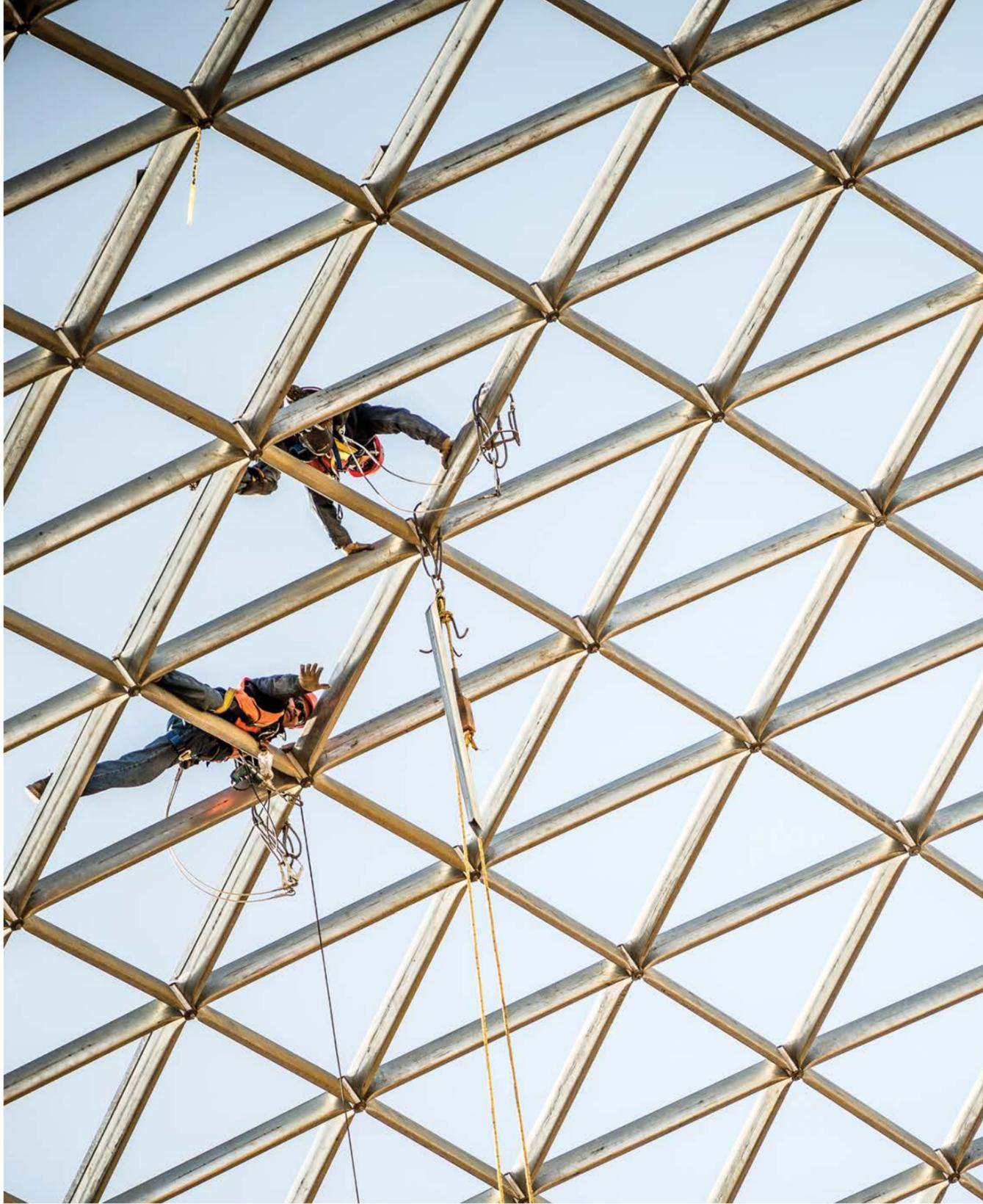
Trabajadores en la construcción del domo geodésico. Este domo tiene una capacidad de almacenamiento de 300,000 toneladas de mineral.
