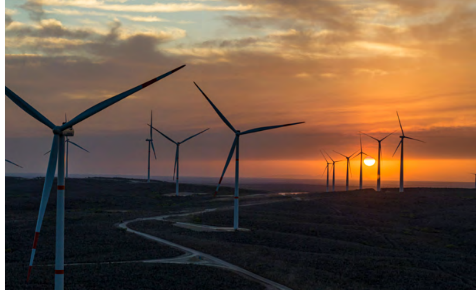
📷 Parque Eólico Fenicias con una capacidad total instalada de 168 MW en Nuevo León, México.
