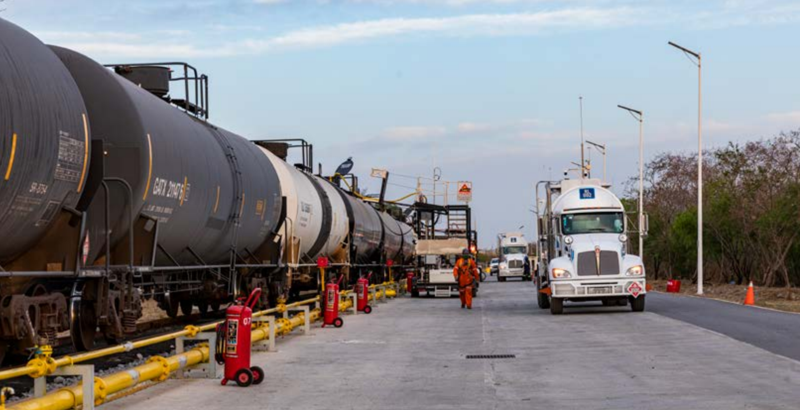
Terminal de Combustibles en Cadereyta, Nuevo León, México.
